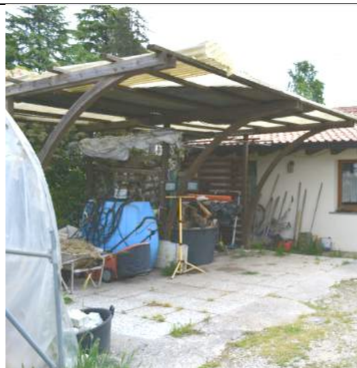
Tettoia in legno di forma non compatibile
