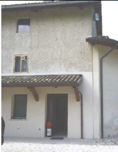
Copertura in laterizio con struttura in legno
