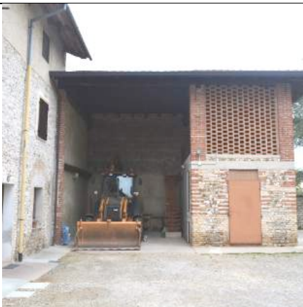
Nella trasformazione i volumi e le aperture, anche se chiusi con serramenti, devono essere riconoscibili.
