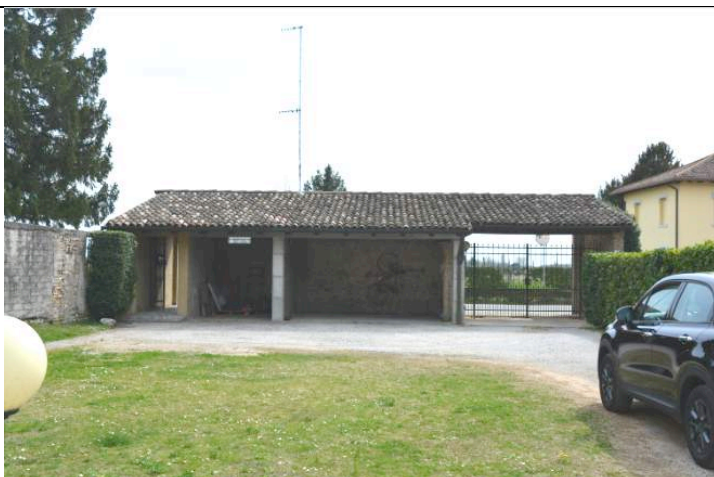
Buon inserimento e corretta realizzazione della tettoia con l'accesso
