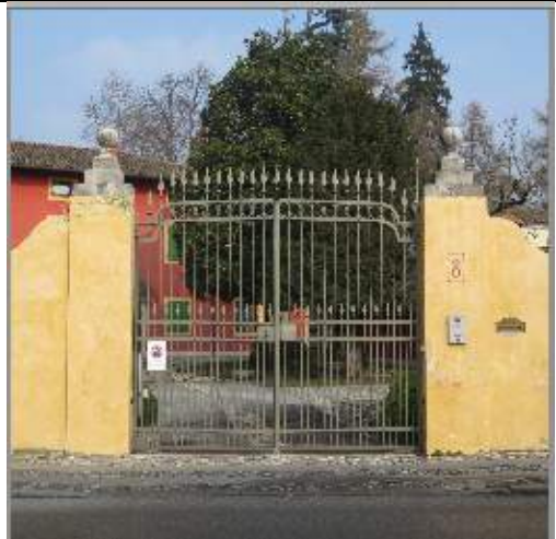
Cancello e muratura
