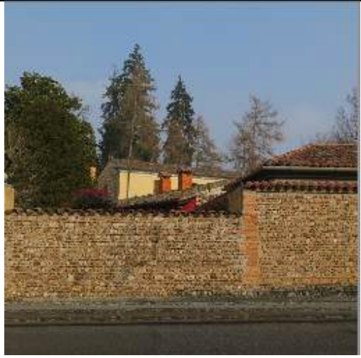
Muro in corsi di pietra e laterizio
