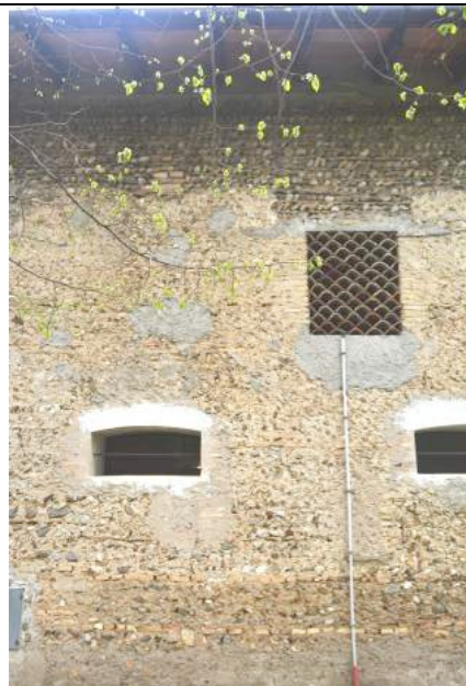
Buona tessitura di muratura in sacco con stilatura, da mantenere
