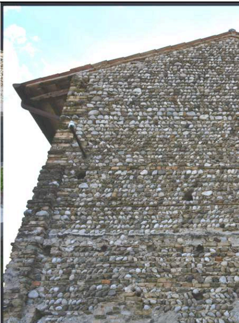
Buona tessitura di muratura in sacco con corsi in laterizio, da mantenere
