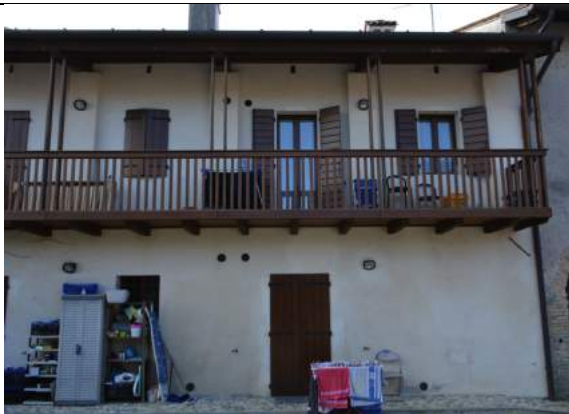
Materiali, dimensioni, copertura compatibile. Il ballatoio è compatibile se preesistente, non è proponibile ex-novo
