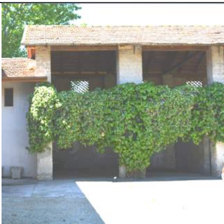
Mantenimento delle ampie aperture agricole che possono essere chiuse con serramenti anche in metallo brunito.
