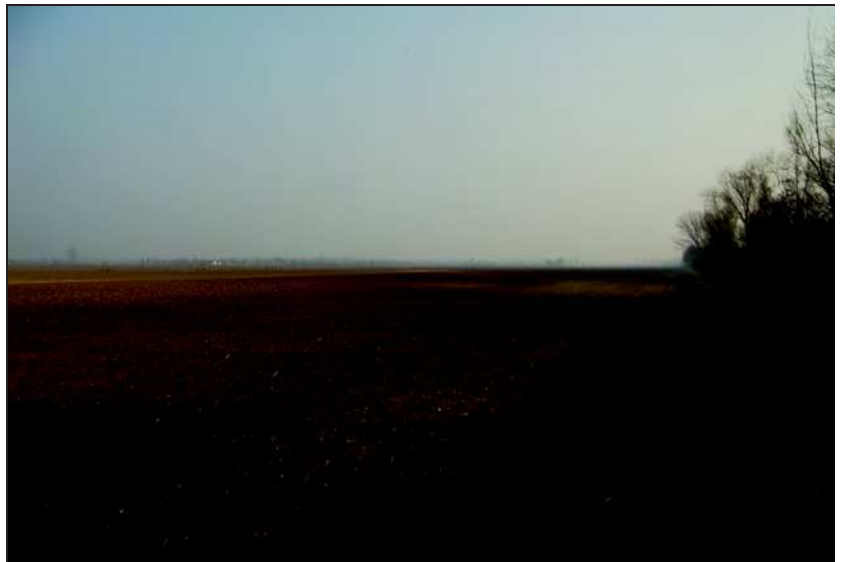
Assenza di vegetazione all'esterno del corpo arginale del Torrente Corno
