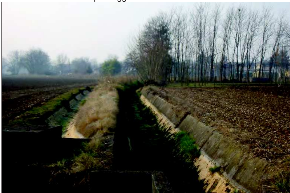
Esempio di canalette adacquatrici in cemento utilizzate per gli apporti idrici con il sistema a scorrimento presente nella parte settentrionale del PAC
